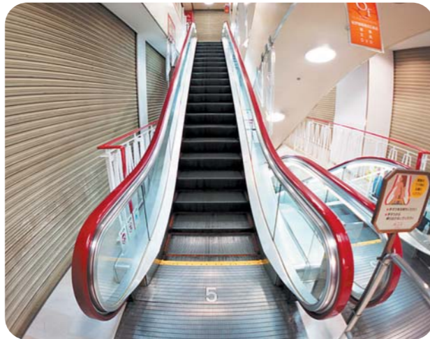
■清掃後(清掃+樹脂コーティング)
